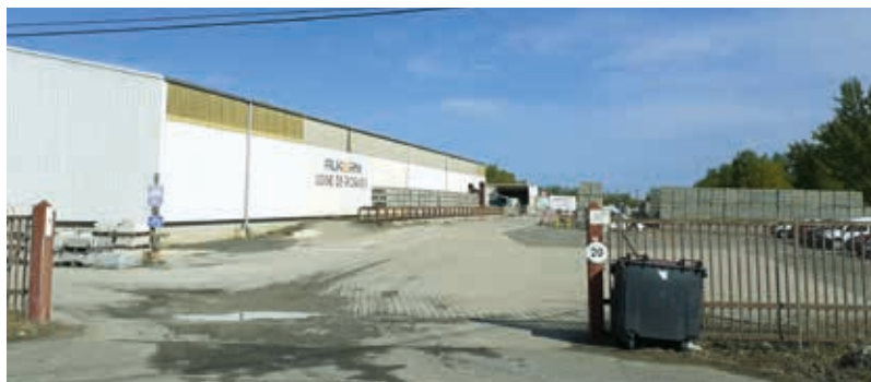
Site de Roques sur Garonne
